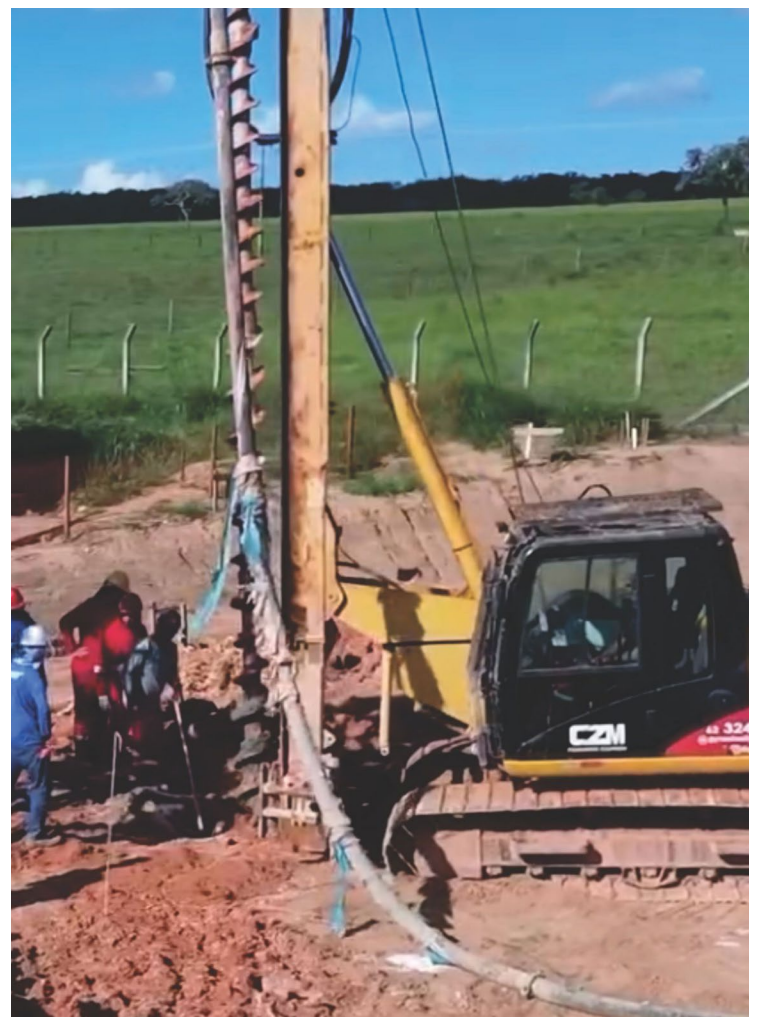
Obras do novo complexo de tratamento e abastecimento na Eta Coqueiros - Foto: Comunicação/Prefeitura Municipal
